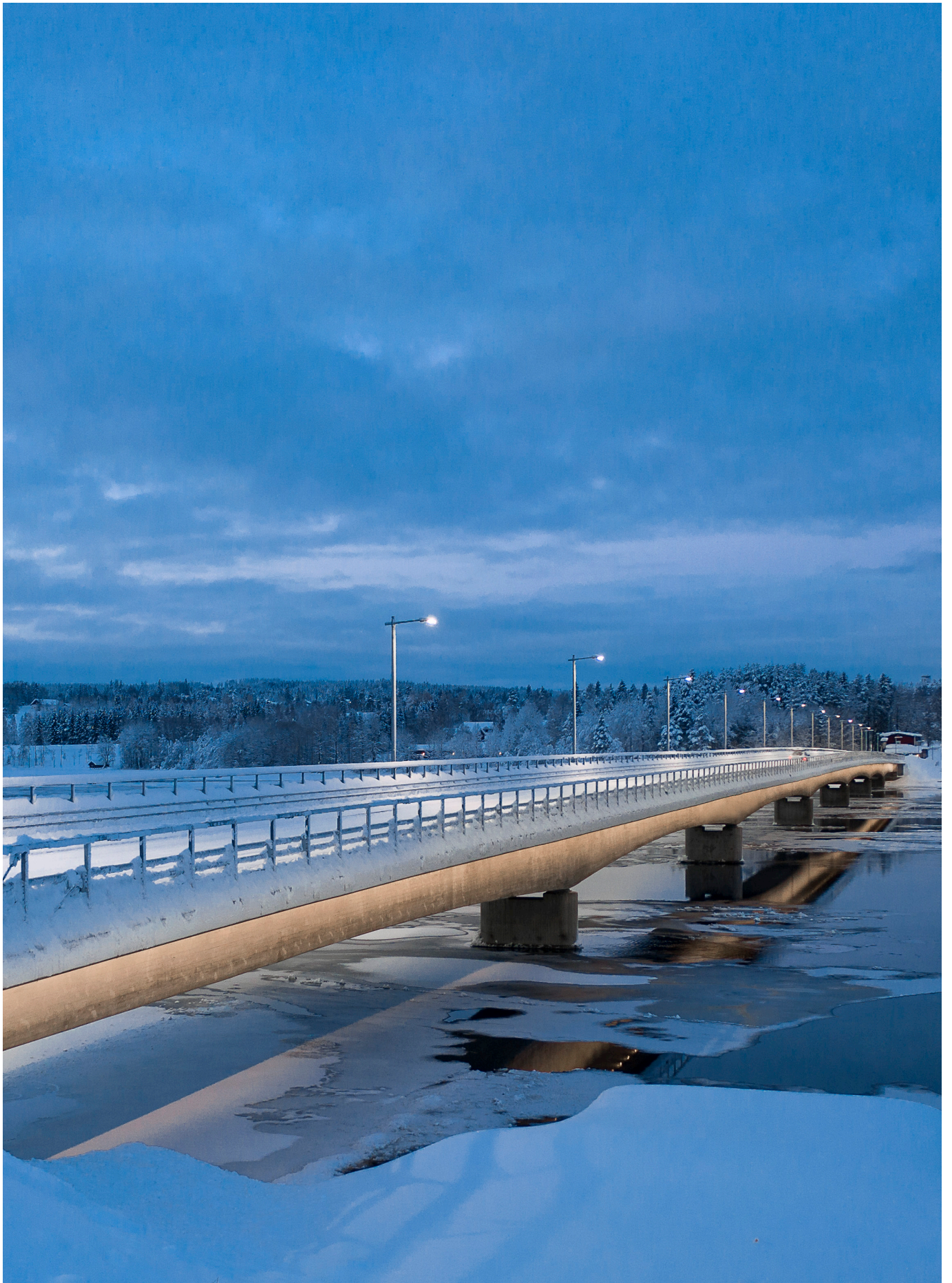
Bro över Indalsälven vid Lit.
